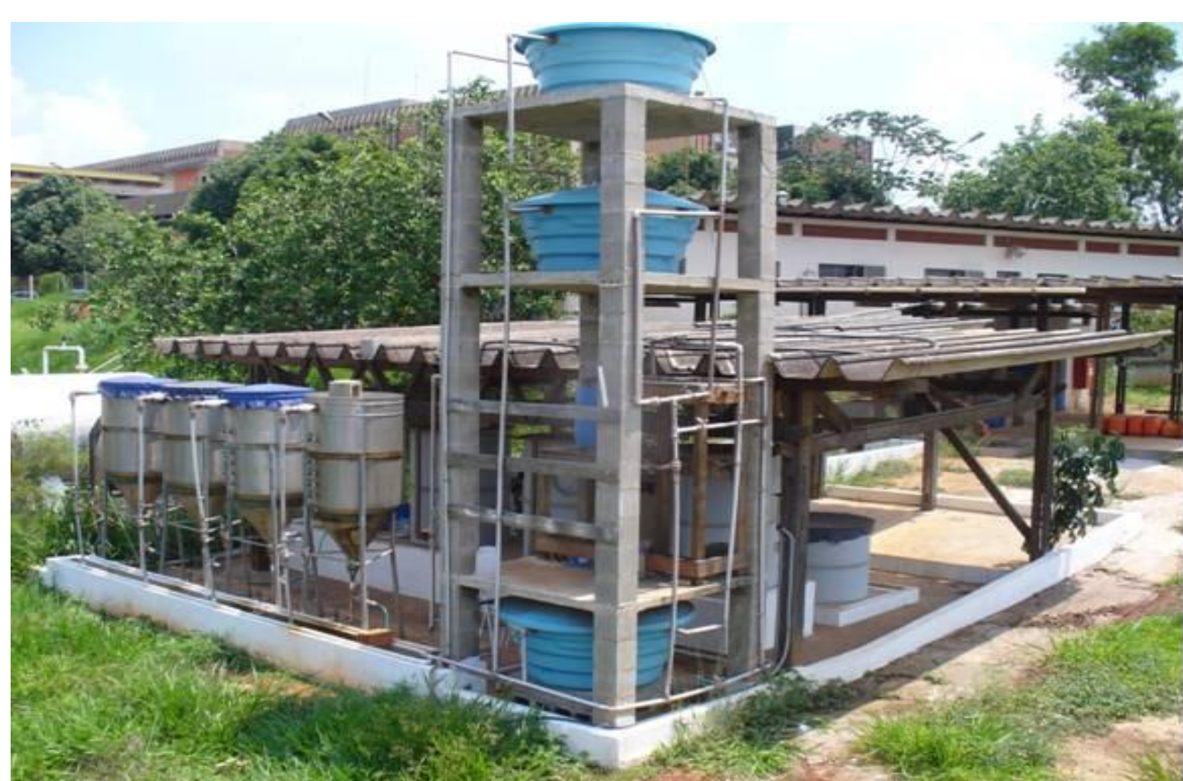
Figura 1: Vista geral das instalações da pesquisa
