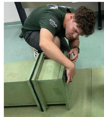
Figura 2 - Uso de uma Camada de Material EVA nas Junções das Partes Anexas do Tubo, Para Garantir uma Maior Vedação.
