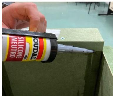
Figura 3 - Aplicação de Silicone nas Emendas Internas do Tubo Para uma Melhor Vedação Acústica.
