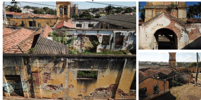
Figura 1: Estado de conservação Fábrica São Martinho – 2023
