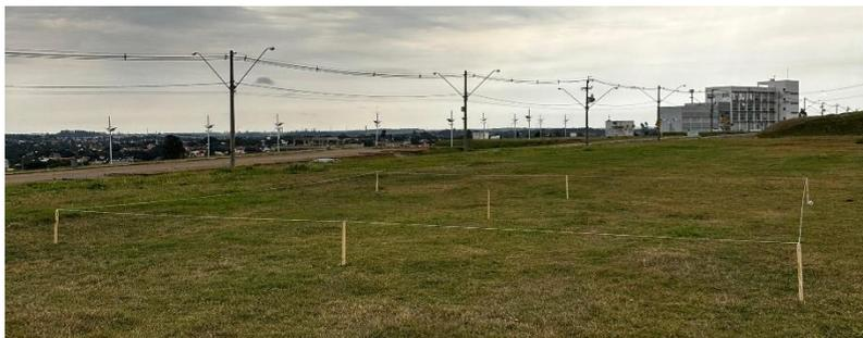
Figura 3 – Foto do delineamento de um quadrado de 8 metros de lado. Feito baseado nos princípios de linha e ângulo explicitados no texto, sobre uma superfície horizontal. Os lados do quadrado estão orientados para os pontos cardeais. Fonte: foto autoral.
