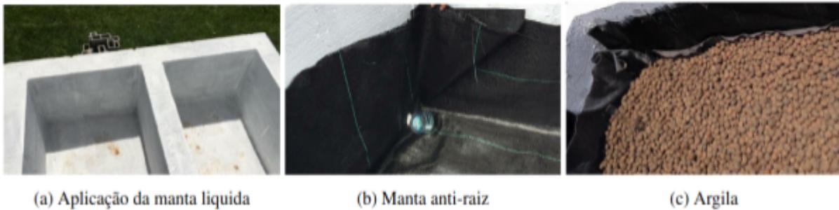
Figura 2 - Camadas do telhado verde
