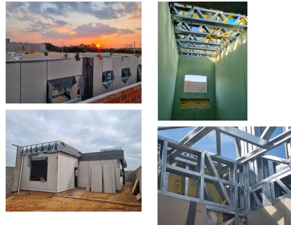
Fig. 4 – Etapas de construção - Método construtivo industrializado
