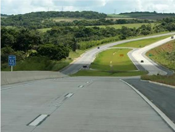
Fig. 5 – Pavimento de concreto - trecho da BR 101 na Paraíba (2008).
