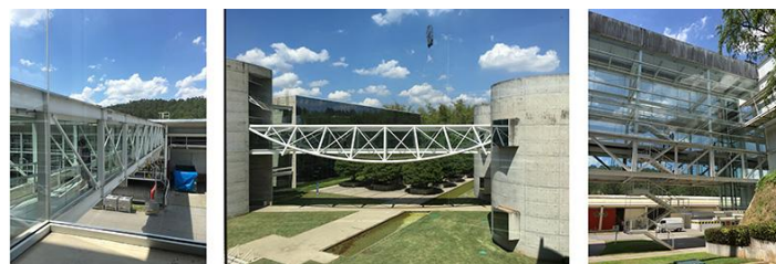
Figura 2. Passarelas. Fonte: Autor, 2017.
