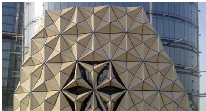
Figura 2. Al Bahar Towers, destaque para fachada.
