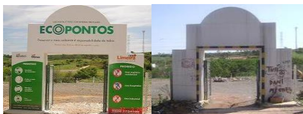
Figura 1: O antes e depois da fachada do ecoponto do Jardim Anavec
