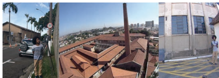
Figura 1. Aluno operando o laser scanner 3D e o VANT, imagem aérea do Edifício Prada.
