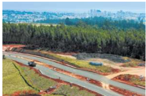
Foto: Obras da Nova Avenida Mackenzie, no Eixo de Expansão da Rodovia D. Pedro I, de Campinas. FONTE: portal eletrônico de Jornal Local, Campinas, 2 de abril de 2015.
